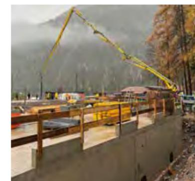
Betonarbeiten an der Decke der Tiefgarage im November (Foto: F. Klotz)
